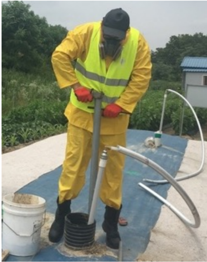
Буріння могильника ямного типу та закладка перфорованих труб
