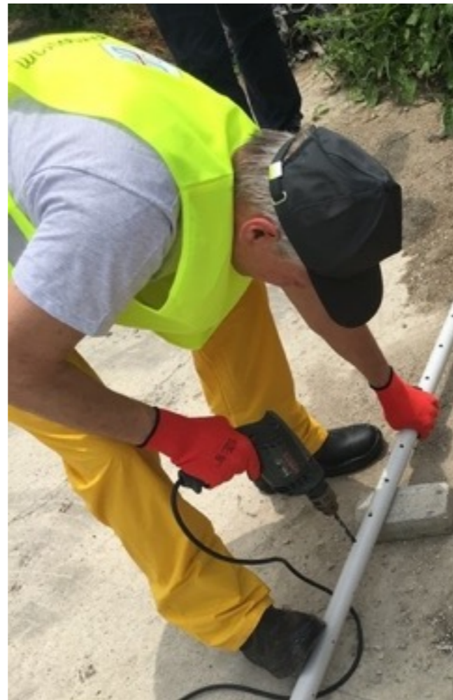
Ігор Сінаєв перфорує трубу, що буде закладатись до могильника
